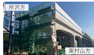
新宿線 東村山～所沢駅間 高架橋構築状況
