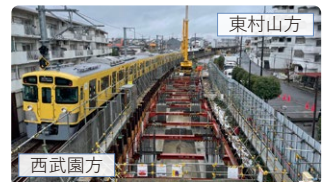
西武園線 東村山～西武園駅間 高架橋構築状況
