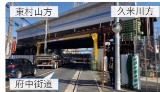
新宿線 久米川第2号踏切道付近 高架橋構築状況
