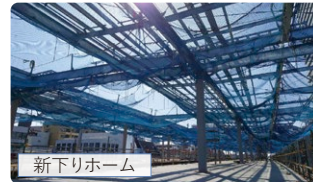
東村山駅 ホーム構築状況
