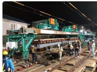
中井方取付部 工事桁架設工事
