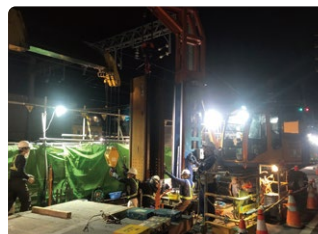
沼袋駅部 土留壁工事
