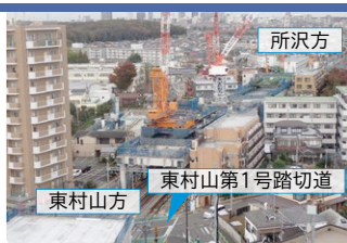
新宿線 東村山第1号踏切道付近 高架橋構築状況
