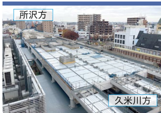
東村山駅 高架橋構築状況
