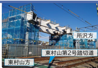
新宿線 東村山第2号踏切道付近 高架橋構築状況
