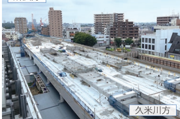
東村山駅 高架橋構築状況
