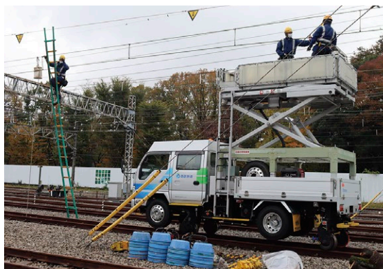
電車線不具合復旧訓練
