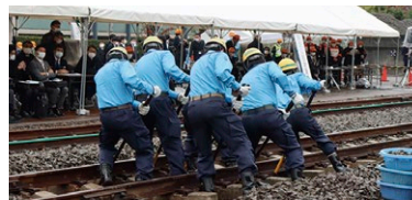
線路変位復旧訓練
