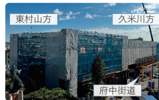
新宿線 久米川第2号踏切道付近高架橋構築状況
