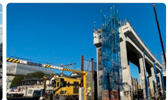
国分寺線 小川～東村山駅間高架橋構築状況
