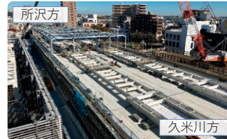
東村山駅 ホームおよびホーム上家構築状況
