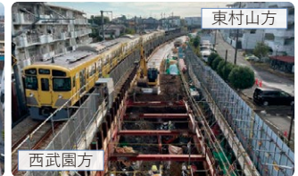
西武園線 東村山～西武園駅間高架橋構築状況
