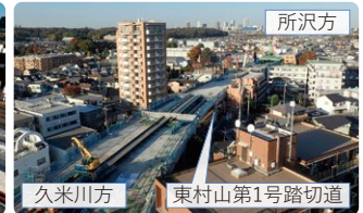
新宿線 東村山第1号踏切道付近高架橋構築状況
