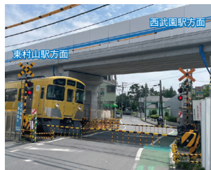
西武園線 東村山第3号踏切道付近 高架橋構築状況
