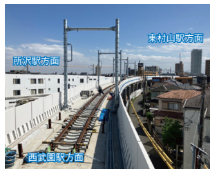
西武園線 東村山～西武園間 軌道・電力工事状況
