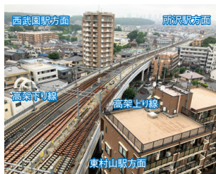
東村山駅部 (新宿線上り線) 軌道工事状況
