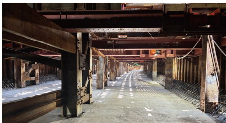
D 野方駅方面取付部 躯体構築工事
