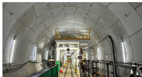
A 中井駅方面取付部 シールドマシン掘進工事
