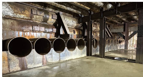
C 沼袋駅部 パイプルーフによる軌道仮受工事
