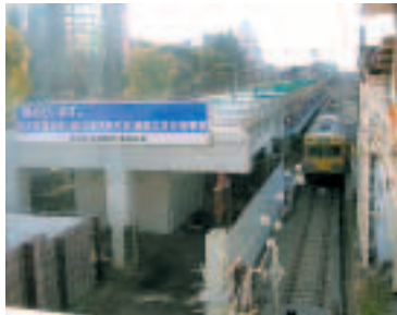
△多摩川線武蔵境駅付近高架化工事
