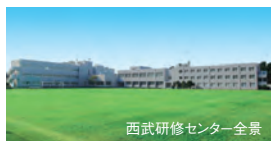
西武研修センター全景
