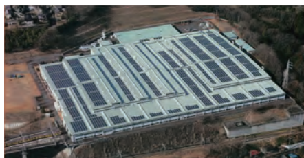
太陽光パネル設置の様子
