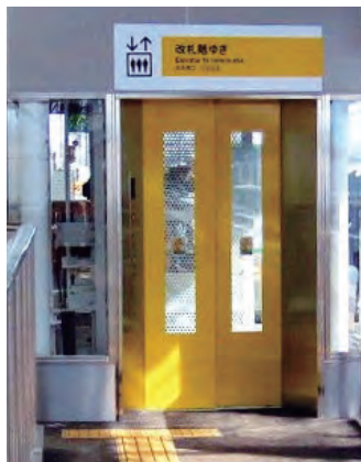
エレベーター(武蔵砂川駅)
