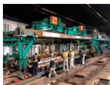
中井方取付部工事桁架設工
