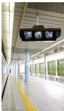
点字誘導ブロック
