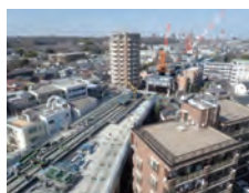
東村山駅高架橋構築状況
