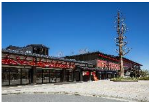
西武秩父駅前広場
