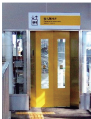
エレベーター(武蔵砂川駅)
