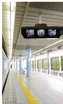
点字誘導ブロック
