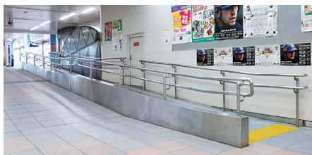
スロープ(本川越駅)
