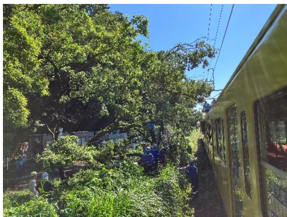
復旧作業の様子
