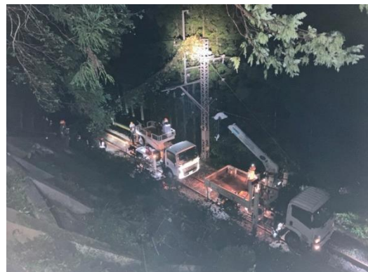
<軌陸車による復旧作業の様子>
