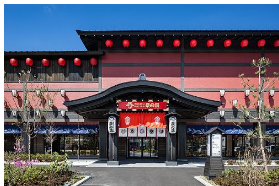
「西武秩父駅前温泉 祭の湯」外観
