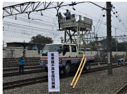
電車線不具合復旧訓練の様子
