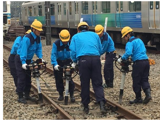
線路復旧訓練の様子
