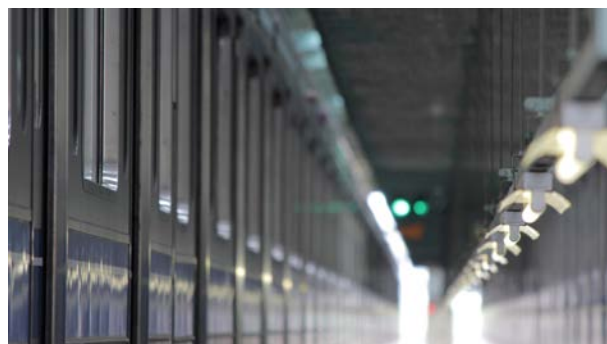
小手指車両基地 ピット内
