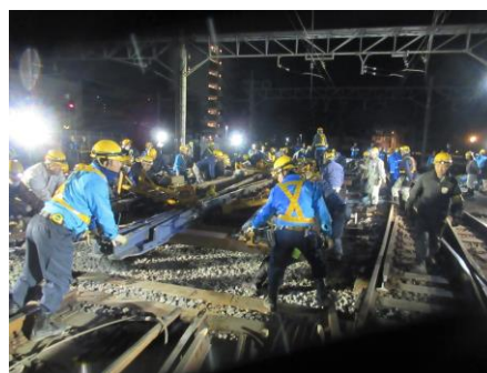
線路の保守工事の様子
