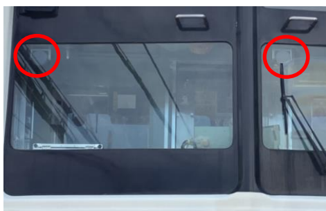
CBTC 車上アンテナ(赤丸部)
