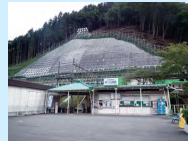
法面改良(芦ヶ久保駅)
