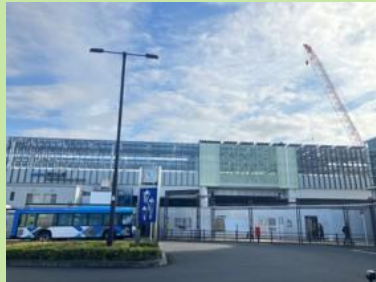
東村山連立の施工状況
