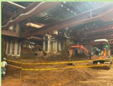
中井～野方連立の施工状況
