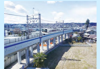
耐震補強工事(秩父高架橋)
