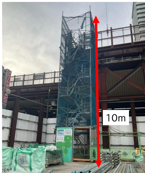
工事用昇降階段
