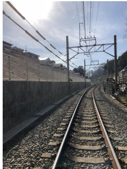
本復旧工事完了後
