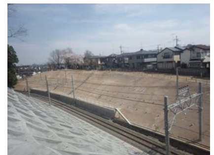
法面（武蔵大和～西武遊園地駅間）
