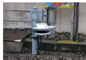
障害物検知装置（池袋8号踏切）
