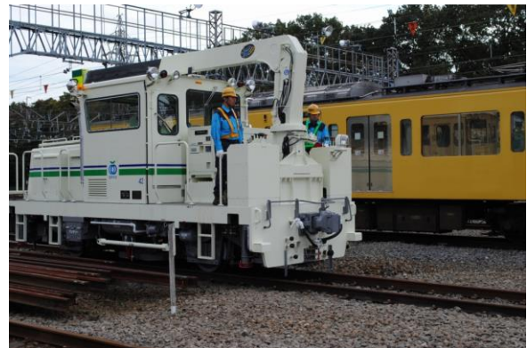
線路復旧訓練の様子
