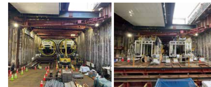
中井駅方面取付部 シールドマシン設置状況
