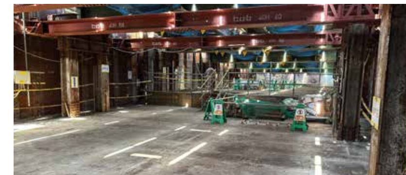
中井駅方面取付部 掘削完了状況
