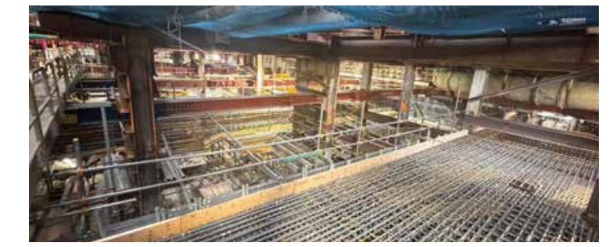
沼袋駅部(中井駅方面) 上床版の鉄筋組立状況
